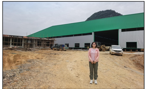
工程师现场踏勘照片
