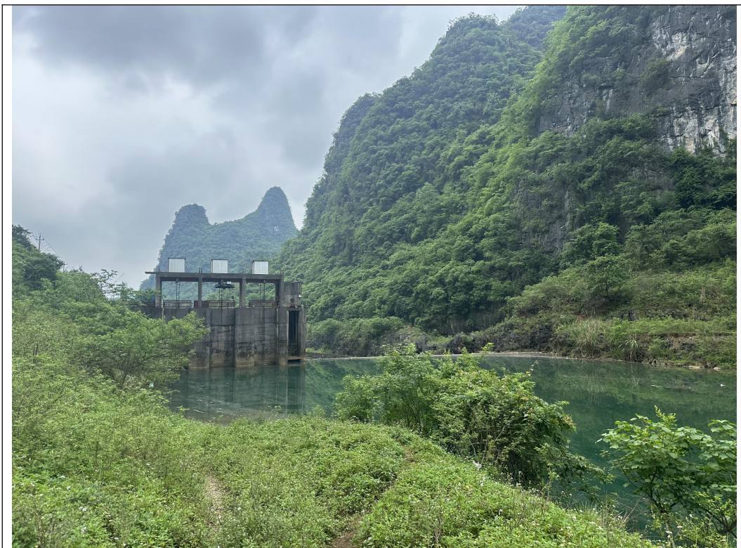
坝上两岸植被和水土保持情况
