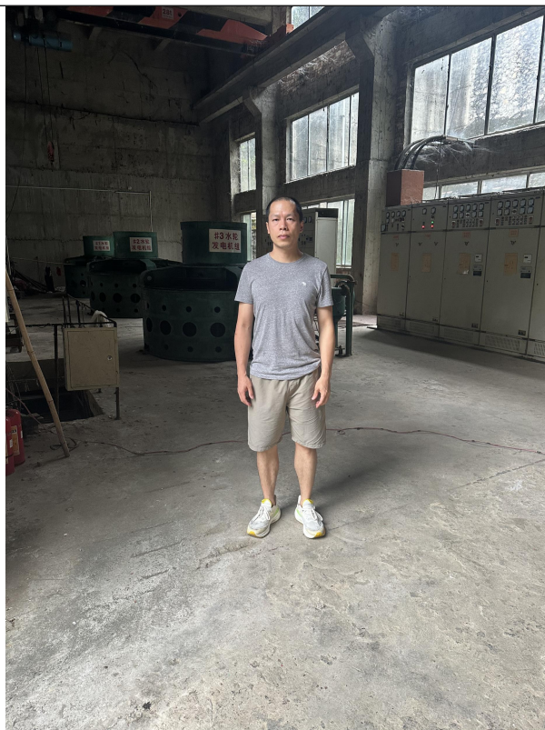
项目编制主持人现场勘察照片
