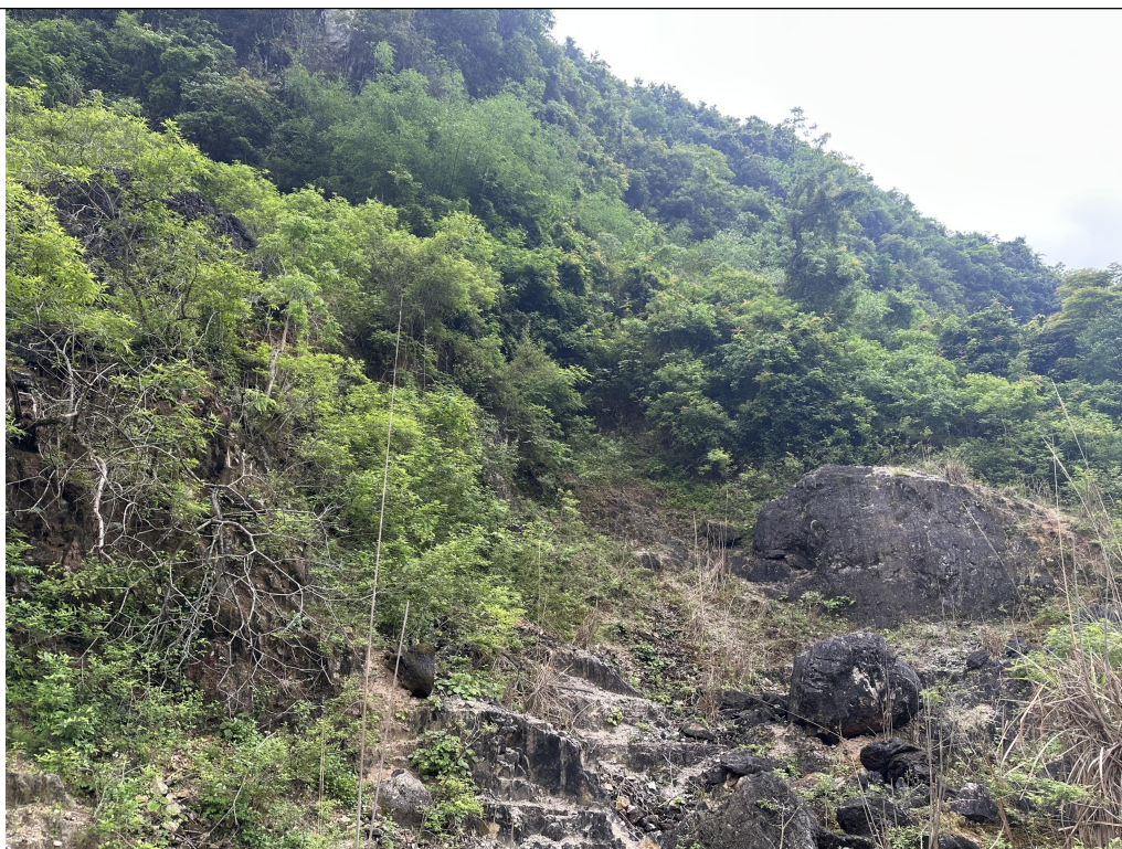
项目坝下右岸植被和水土保持情况
