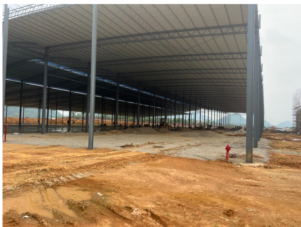
项目车间内部现状
