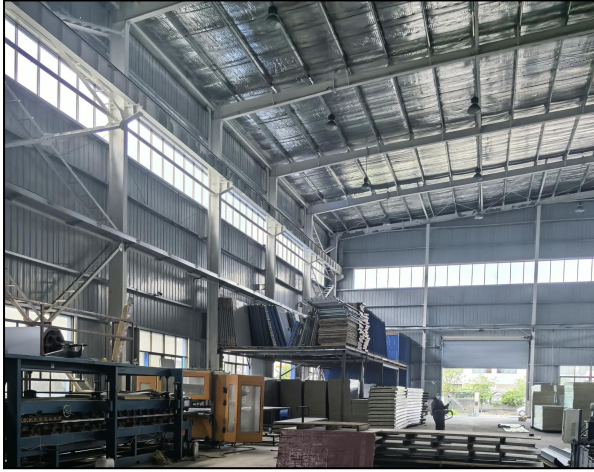
项目车间内部现状图
