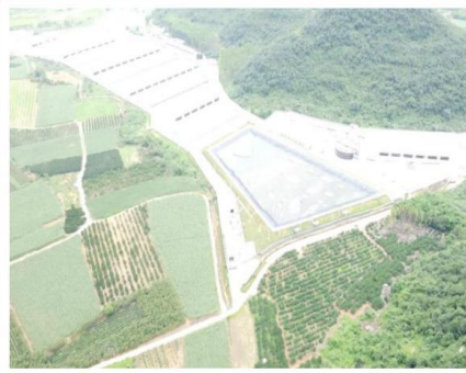
项目东北面 463m 牧原养猪场
