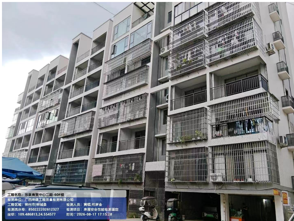
附照片 1: 房屋整体照片
