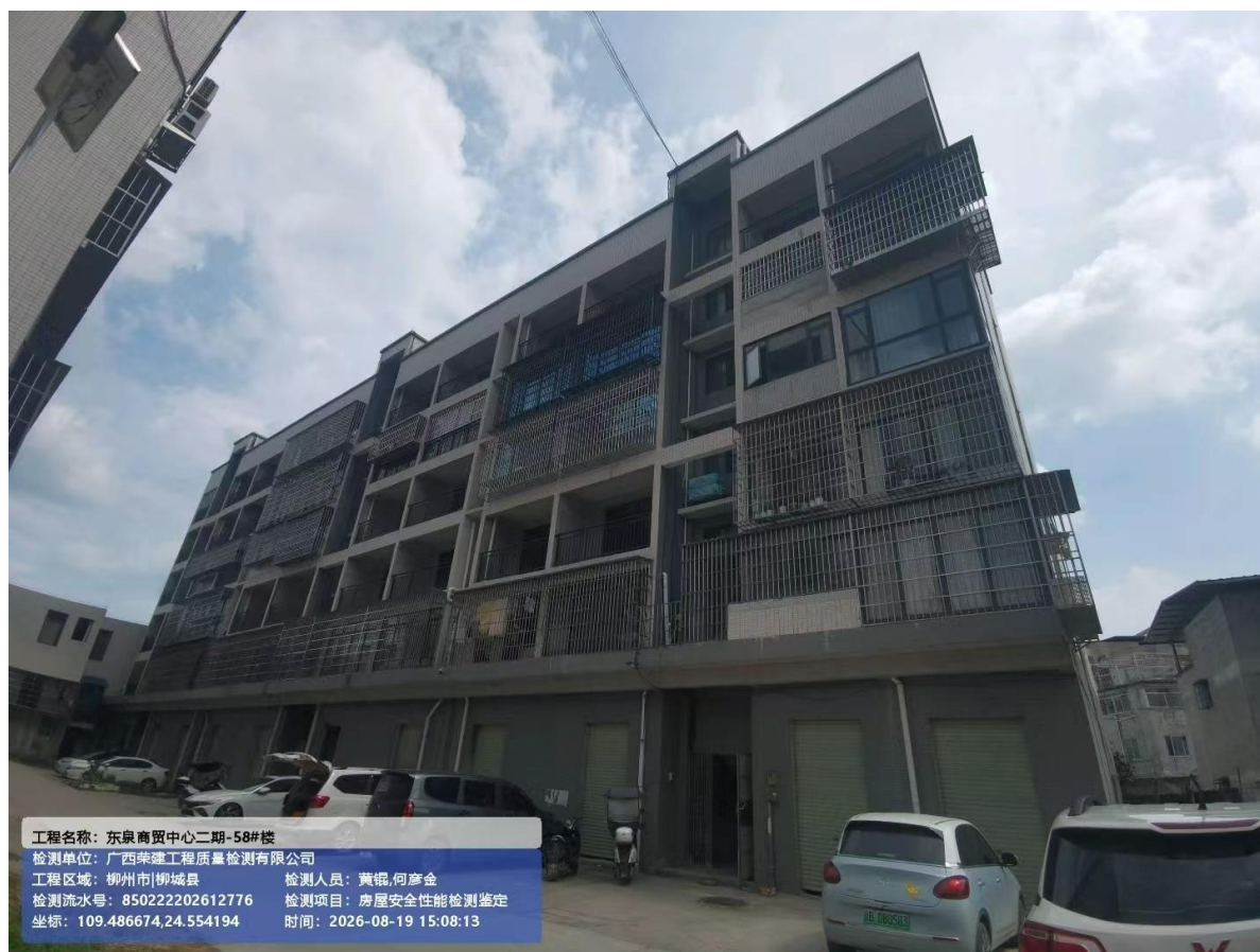
附照片 1: 房屋整体照片
