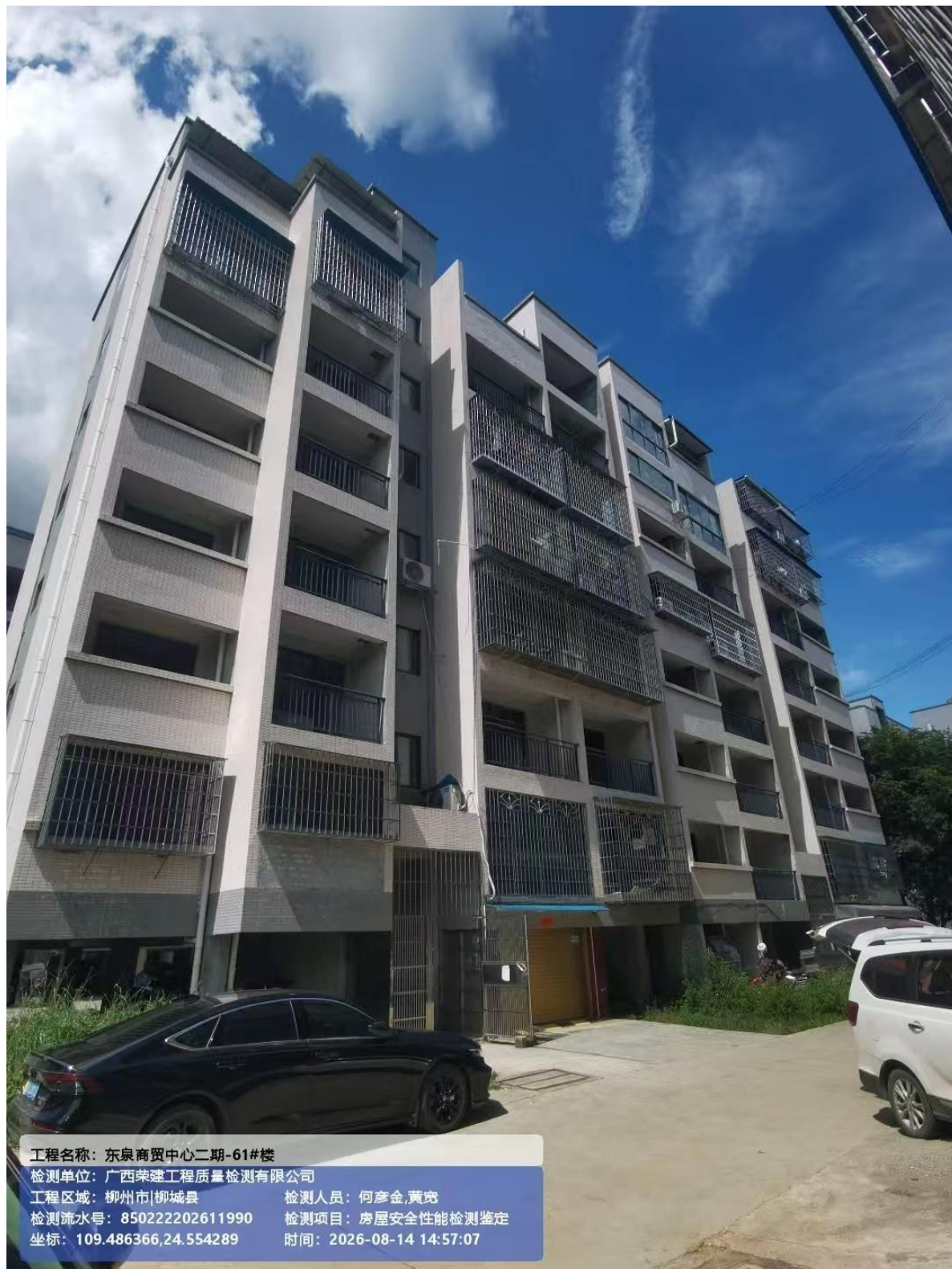
附照片 1: 房屋整体照片
