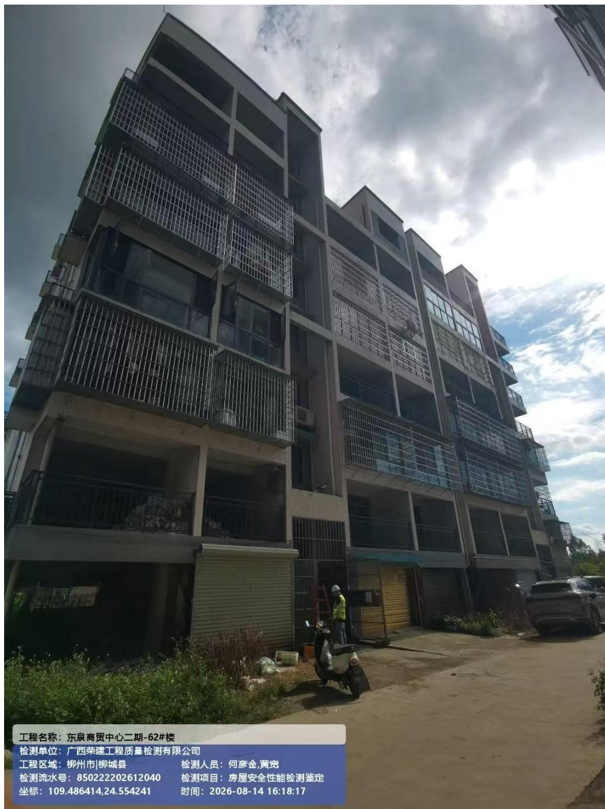
附照片 1: 房屋整体照片
