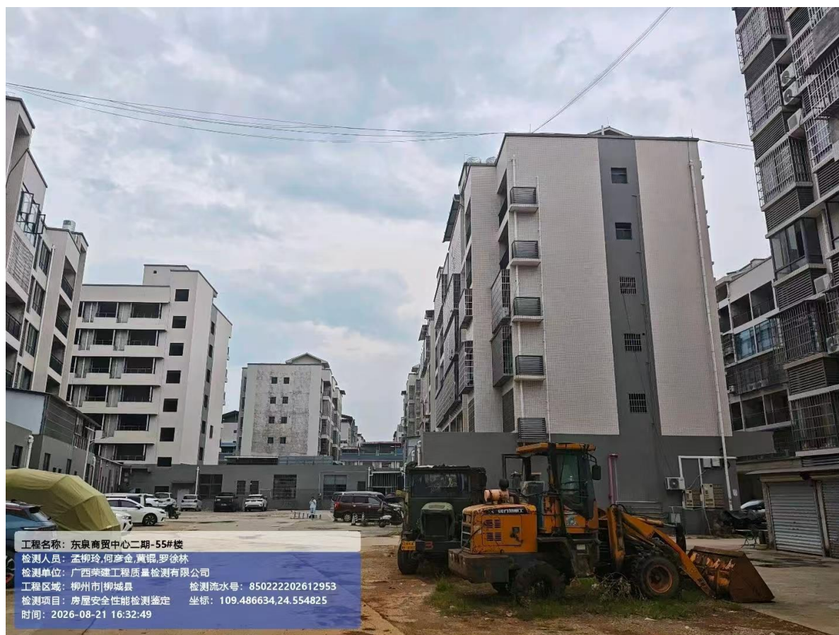
附照片 1: 房屋整体照片
