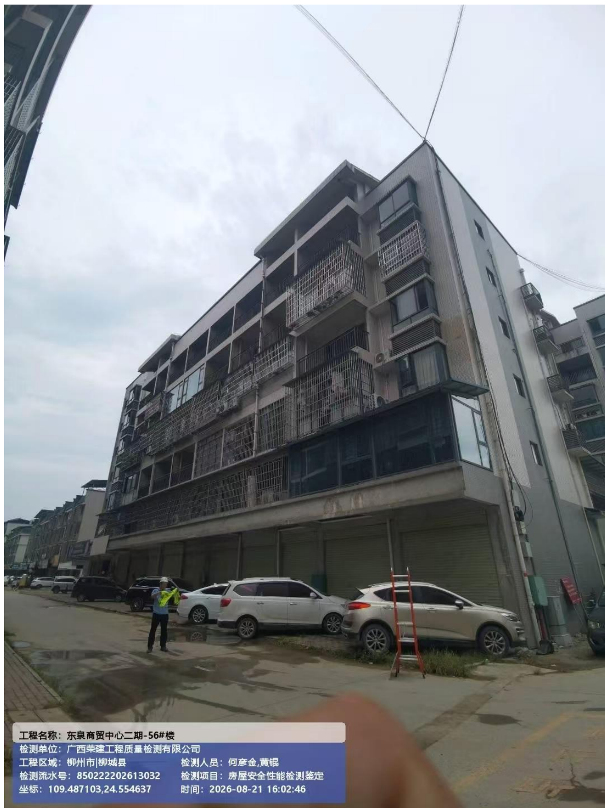
附照片 1: 房屋整体照片
