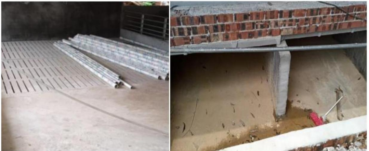
图 2.1.9-3 项目半漏缝、高架网床实景图
